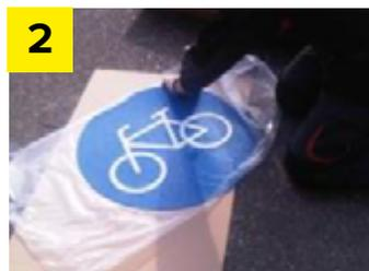
2 Retirez le film de protection, assemblez les pièces individuelles aussi près que possible de la forme correspondante, conformément au schéma ci-joint.
