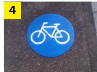
4 Le matériau colle maintenant sur la surface et les voitures peuvent rouler quelques minutes après le refroidissement.
