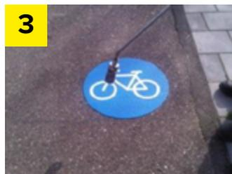
3 Avec un brûleur à gaz en mouvement continu (pour éviter les brûlures ou la décoloration), toute la surface est chauffée jusqu'à ce qu'elle fonde, ce qui est perceptible sur les ampoules à la surface.
